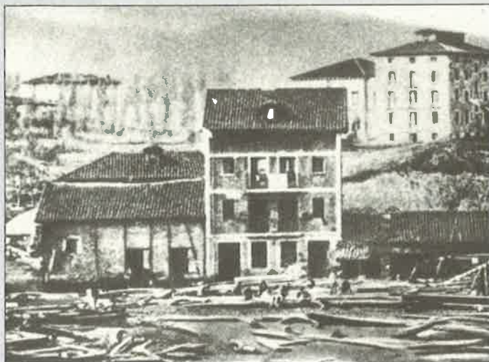
En 1857, Santiago Arana Ansotegi, padre de Sabino, construye en Abando la casa que aparece al fondo, a la derecha, junto a la iglesia de San Vicente. Allí nace Sabino, en 1865. En primer plano, los astilleros propiedad de la familia.
