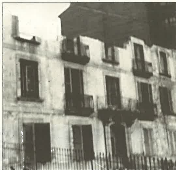
Con el fin de eliminar cualquier resquicio nacionalista, el régimen franquista ordena en diciembre de 1960 la demolición de Sabin Etxea.
